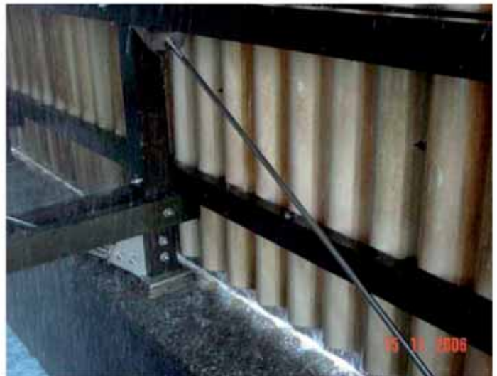
Abb. 2: Photographische Dokumentation eines mit modernen Kombinationssystemen behandelten Kühlturms nach zwei Jahren Laufzeit
