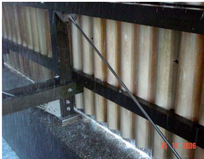
Abb. 2: Photographische Dokumentation eines mit modernen Kombinationssystemen behandelten Kühlturms nach zwei Jahren Laufzeit
